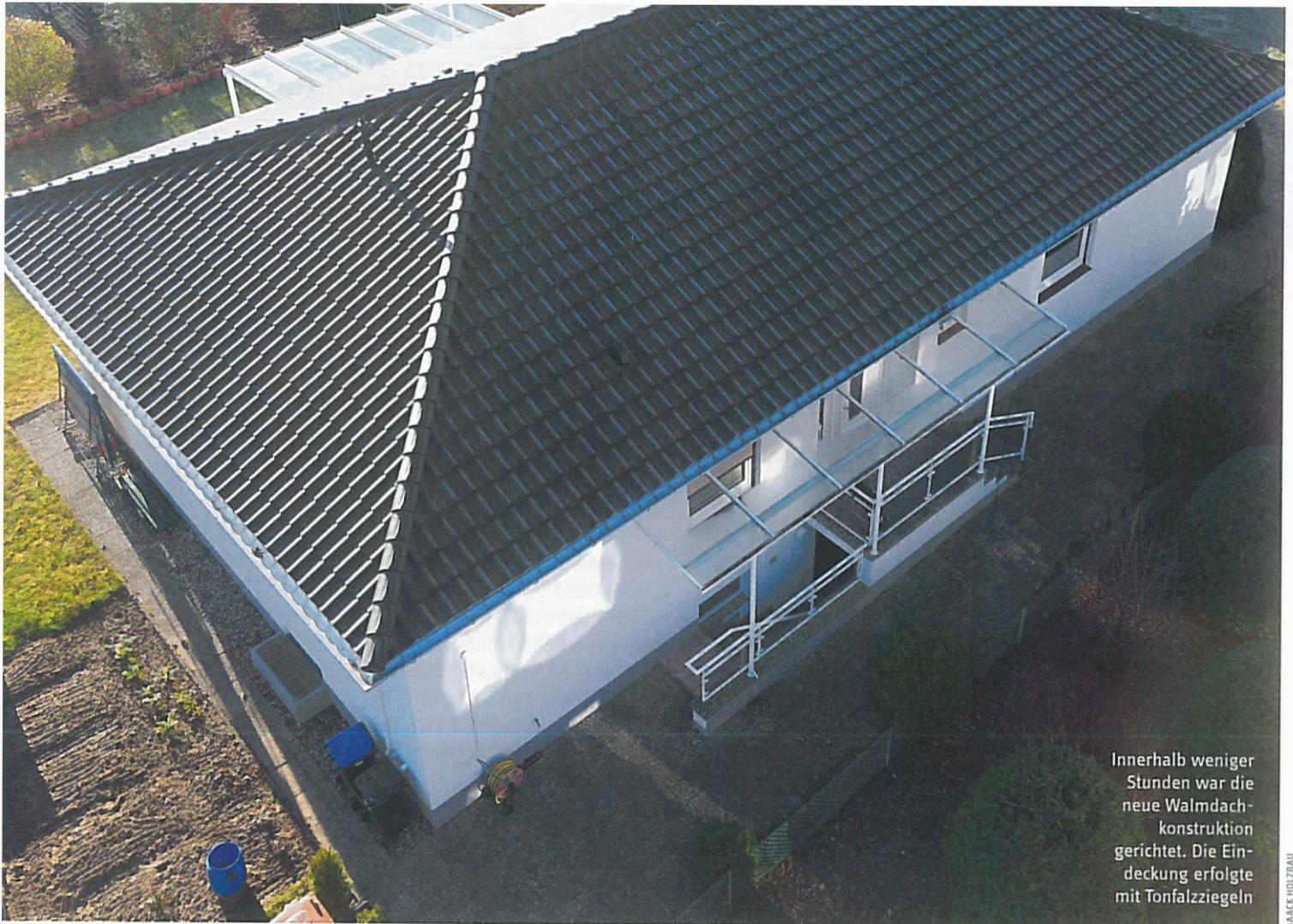
Innerhalb weniger Stunden war die neue Walmdachkonstruktion gerichtet. Die Eindeckung erfolgte mit Tonfalzziegeln
