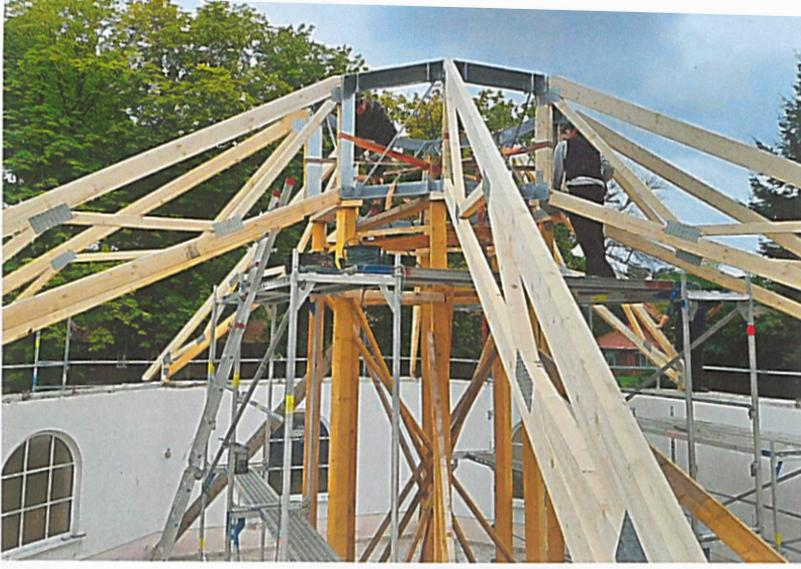
◀ Die neue Zeldachkonstruktion wurde um einen achteckigen Stahlträger konstruiert
