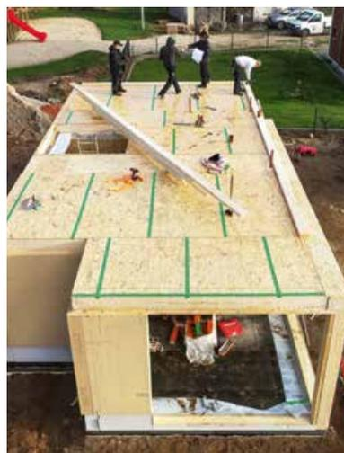
►►► Die oberste Balkenlage, die das Flachdach ausbildet, wird montiert
