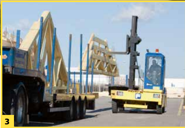
3 Spezialisierte Spediteure übernehmen den Transport auf die Baustelle. Deutschlandweit wird morgens um sieben Uhr geliefert.
