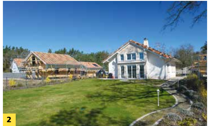
2019: Der Bau der Ferienhäuser schreitet zügig voran.
