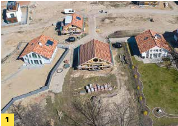
Ferien am Altdorfer See an der Mecklenburgischen Seenplatte: Ende 2016 wird das erste Haus in Holzrahmenbauweise errichtet.
