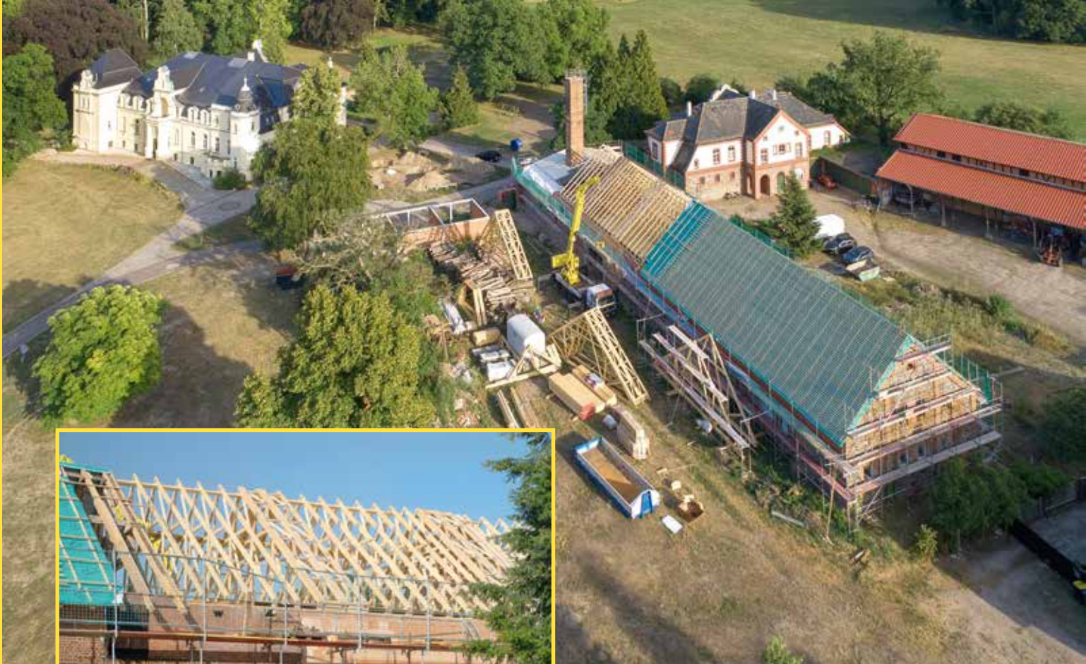
Der Erweiterungsbau schließt die Lücke zwischen verbliebenem Stallgebäudeteil und dem später errichteten Heizhaus – mit neuer Dachkonstruktion von SCHNOOR.
