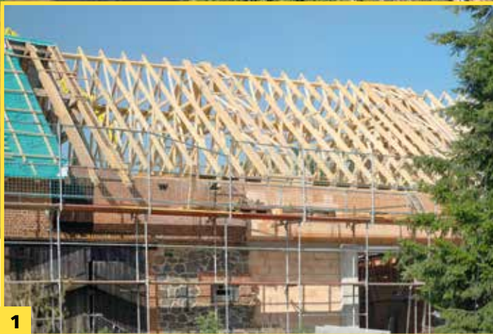
Der Erweiterungsbau schließt die Lücke zwischen verbliebenem Stallgebäudeteil und dem später errichteten Heizhaus – mit neuer Dachkonstruktion von SCHNOOR.
