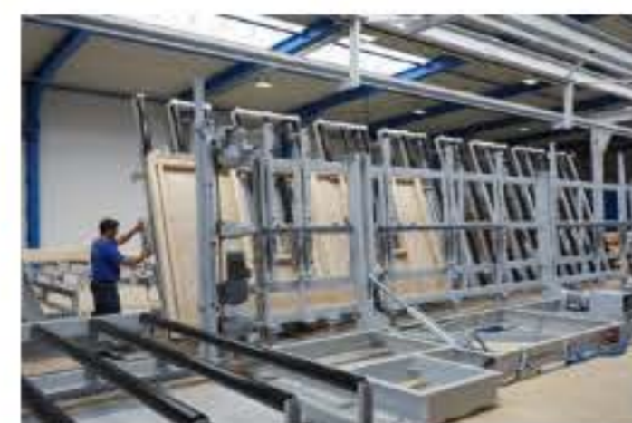
Die hydraulischen Hebebühnen wenden ein Wandelement zur Bearbeitung der Rückseite (Foto: Schnoor)
