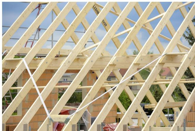
Das Futterholz ist für die Abspannung auf der Kehlbalkenebene optimiert. Eine Abspannung der metallenen Windrispen bis zum First ist nicht mehr erforderlich.
