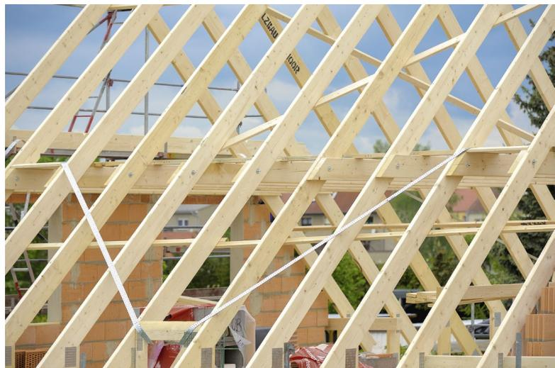
Dachkonstruktion mit V-förmiger Abspannung der Windrispen:
