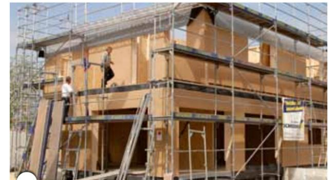
Dank des hohen Vorfertigungsgrades war der Rohbau des Effizienzhauses in nur 2 Tagen komplett montiert.
