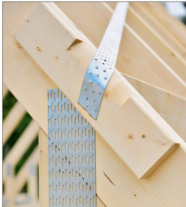
Dank der abgerundeten Oberfläche des Schnoor-Beiholzes ist für die Montage von Windrispenbändern kein weiteres Hilfsmittel erforderlich
