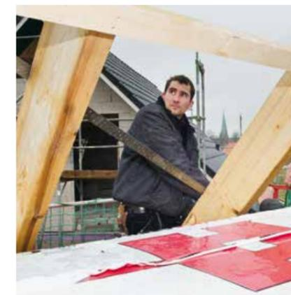
▲ Die Gebinde wurden nach Herstellerplan per Kran eingeschwenkt und in den Balkenschuhn befestigt. Zum Schluss erfolgte die Montage der Windrispen
