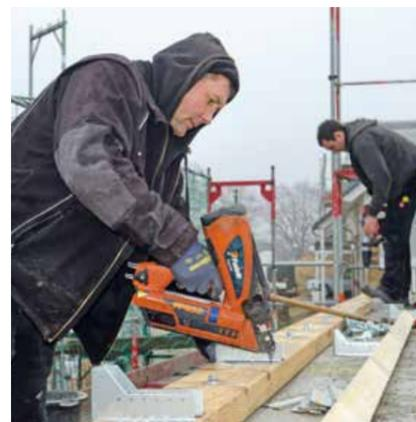
▲ Nachdem die Gebinde montiert waren, verankerten die Handwerker die Schwellen in der Betondecke und befestigten darauf die Balkenschuhe
