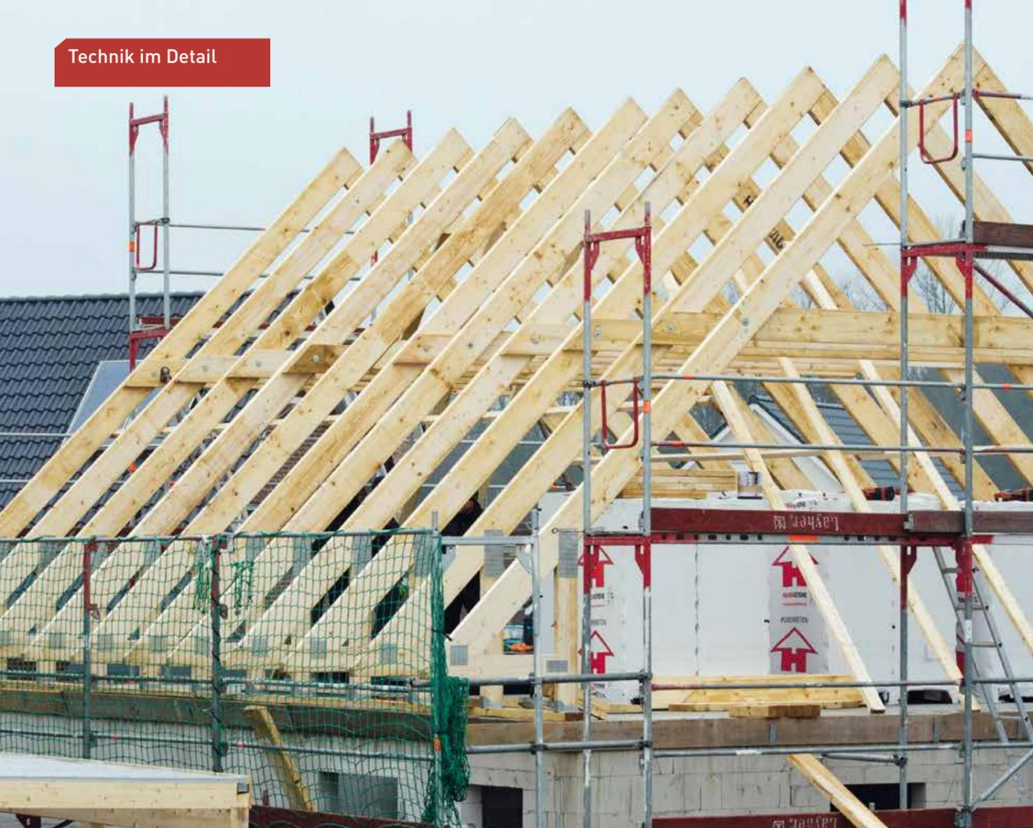
▲ Schnell montiert: Für das Aufrichten der elf Gebinde dieses Dachstuhls in Trittau brauchten vier Handwerker lediglich einen halben Arbeitstag
