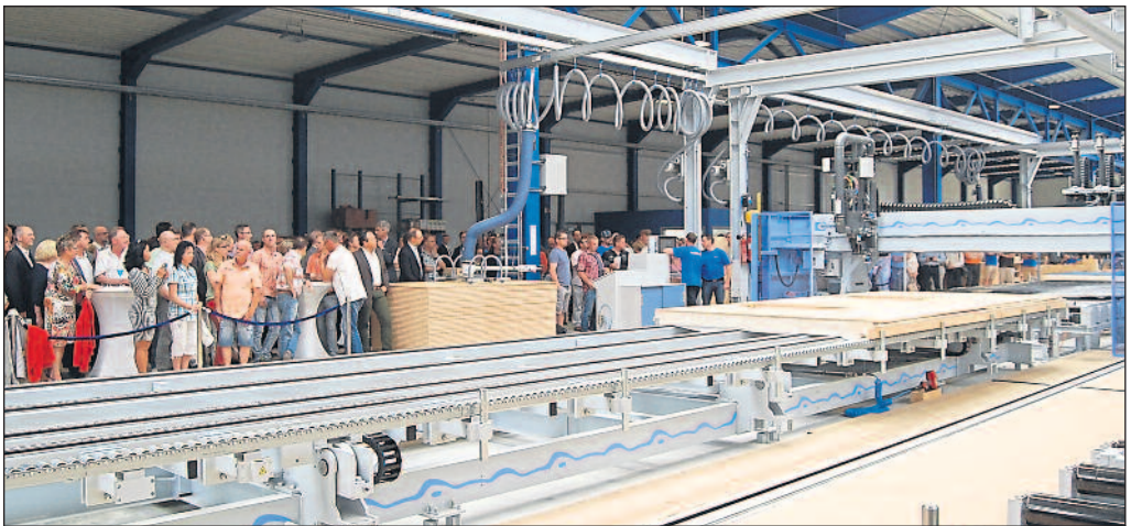
Eine Premiere: Die Gäste bestaunen die neue Anlage, während diese ein Wandelement anfertigt.
