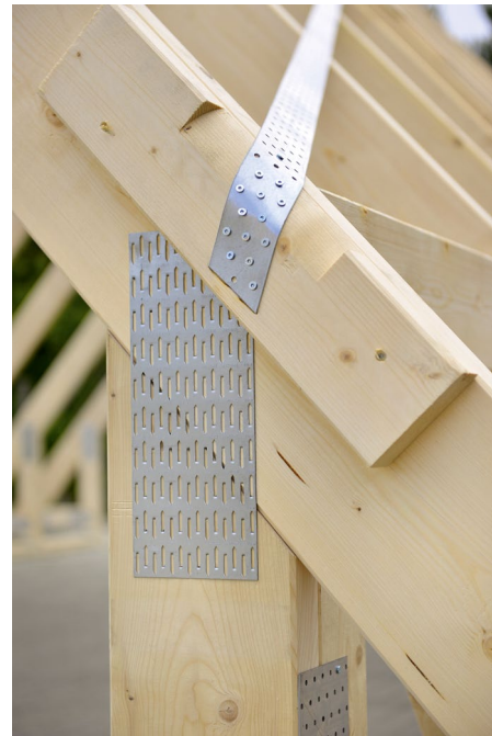
Das Windrispenband wird ohne Kantenpressung über eine speziell abgerundete Oberfläche des Beiholzes geführt.
