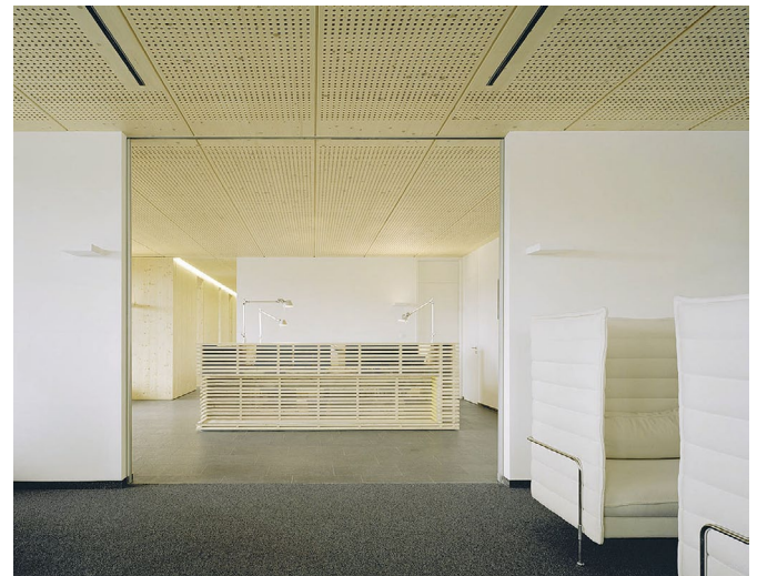
Die Deckenelemente tragen über große Spannweiten – so ermöglichen es ihre statischen Eigenschaften, große Räume ohne Stützen und störende Unterzüge zu realisieren.
