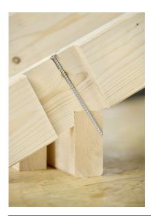
Beim neuen Schifter-Schraubanschluss hält eine 2 cm tiefe Führungsbohrung die Vollgewindeschraube sicher auf Kurs. Erforderliche Randabstände werden präzise eingehalten. Das zeitraubende Einmessen und Justieren der Schraube entfällt.
