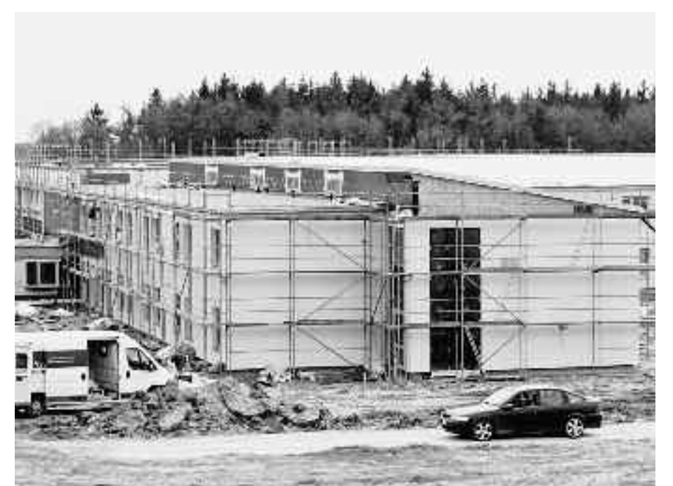
Die Dachkonstruktion von Schnoor steht bereit; finale Arbeiten laufen noch. Foto: Schnoor
