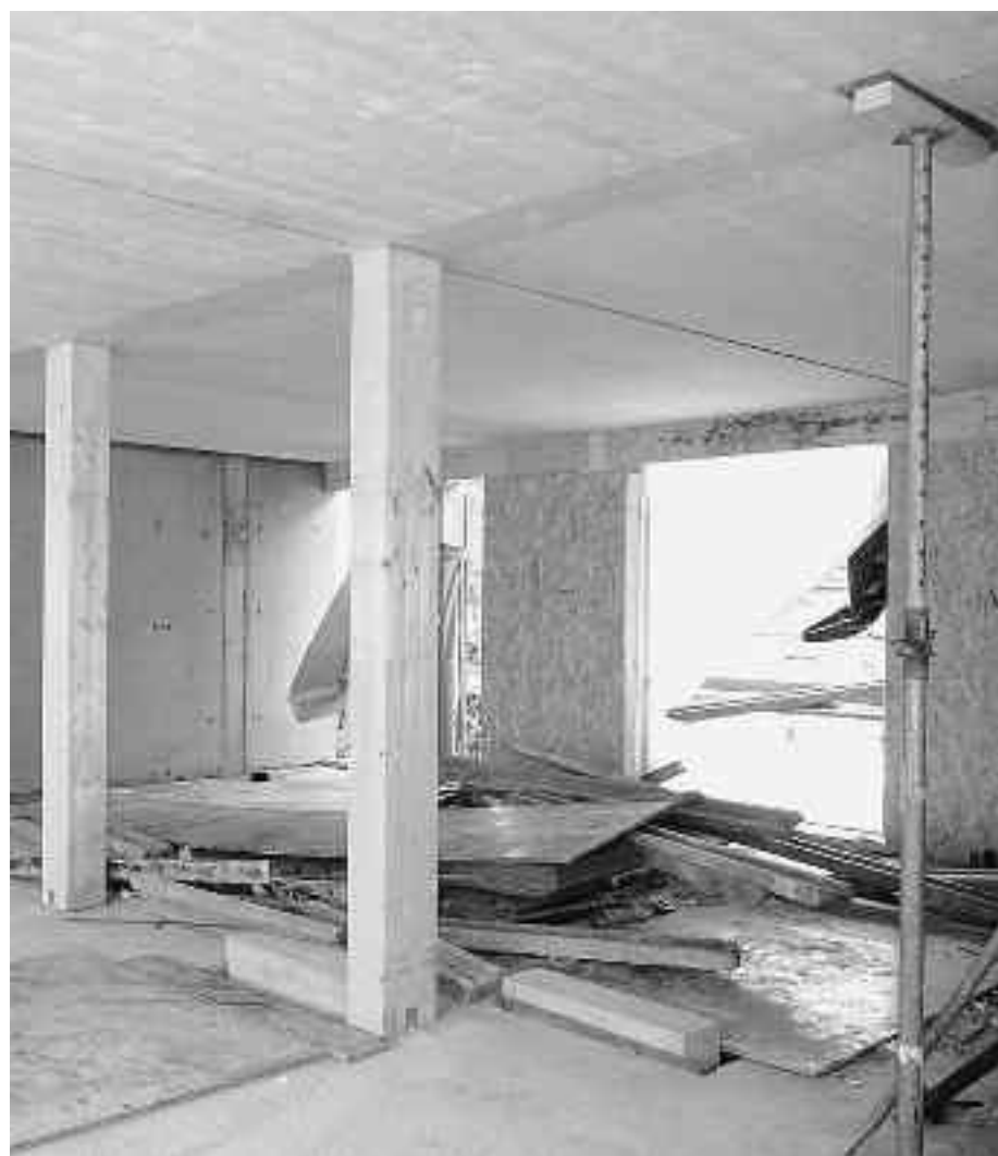
Deckengleiche Unterzüge im Fünf-Geschosser „3XGrün“, Berlin.
