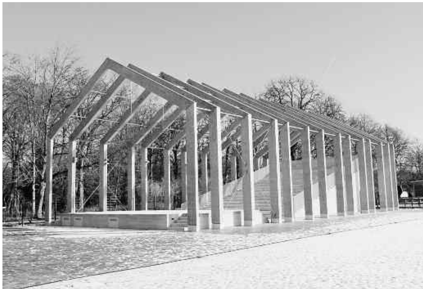
Frei bewitterte tragende Konstruktion der Freilichtbühne Gutshof Britz.
