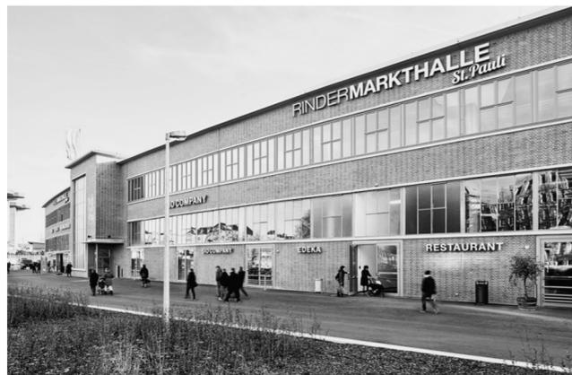
Sowohl die ehemals vorhandenen Fensterbänder im Zwischengeschoss als auch die Stahltore wurden zwar durch neue, historisch anmutende Fenster und Tore ausgetauscht, diese aber in der bauzeitlichen Ursprungslage und Aufteilung z. T. an den noch bestehenden Stahlunterkonstruktionen eingesetzt. Fotos: Ulrich Hoppe
