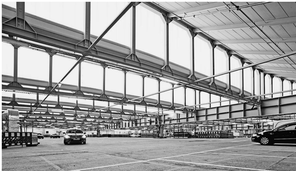
Das gesamte Tragwerk wurde vollständig gestrahlt und neu beschichtet. Aufgrund der vorhandenen Lastannahme aus dem Umbau mit Kunststoff-Trapezverglasung wurde die neue Sheddach-Verglasung als 2,6 m hohe Doppelsteg-KU-Fenster-Konstruktion umgesetzt.
