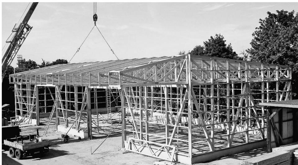
Dach und Wand aus einer Hand: Das komplette Holzskelett dieser Halle wurde von Ing.-Holzbau Schnoor in Nagelplattenbinderbauweise geplant und vorgefertigt. Das geräumige Gebäude gehört der traditionsreichen Holzhandlung Freese und steht in Wattenbek/Schleswig-Holstein. Foto: Ing.-Holzbau Schnoor
